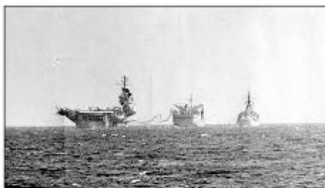
Заправка кораблей траверзным способом
